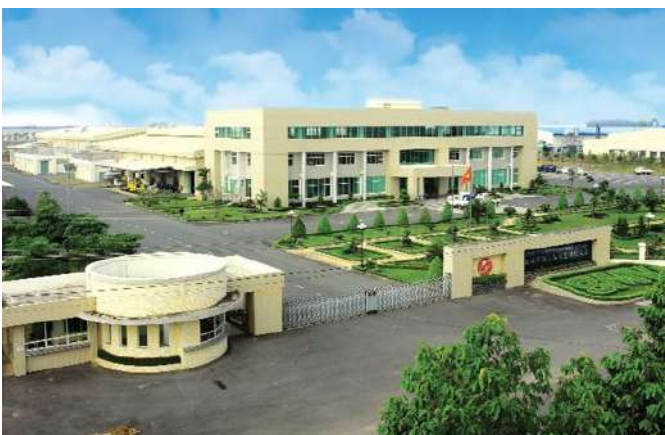
Nhà máy SYM - Nhơn Trạch 3
